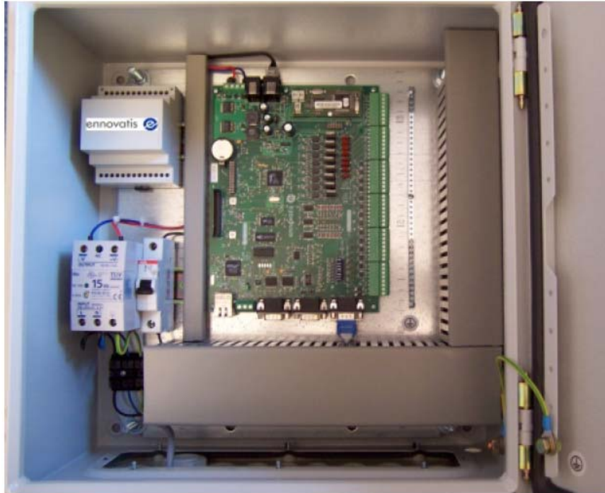
Abbildung 1 Aufbau der ennovatis Smartbox für Nichtwohngebäude
